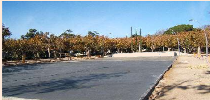
Parque Central de Mataró, acabándose su nueva pavimentación
